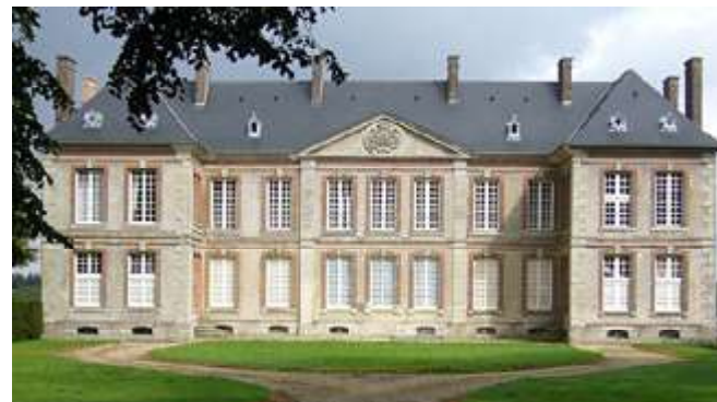
Château des Mercastel à Saint-Samson-La-Poterie (60)
