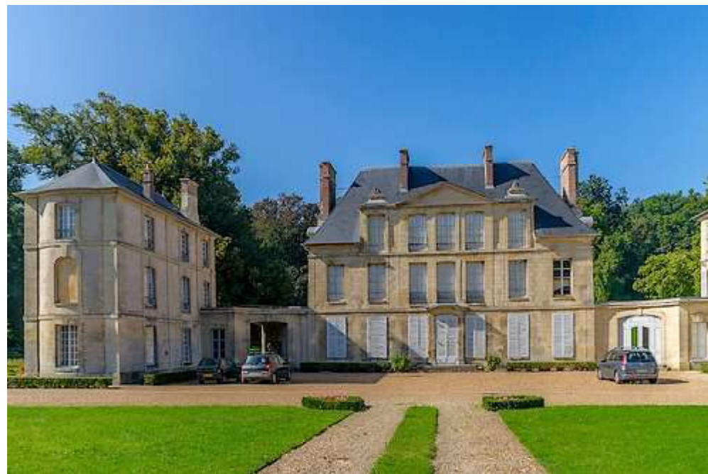
Château des Aguesseau à Puisieux (60)
