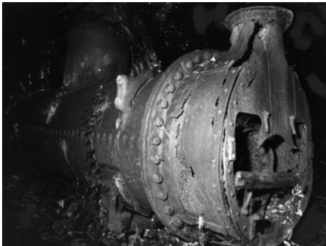
A gauche : les restes de la chaudière du captage du Marmot sont encore bien visibles près des ruines du poste d'entretien.
