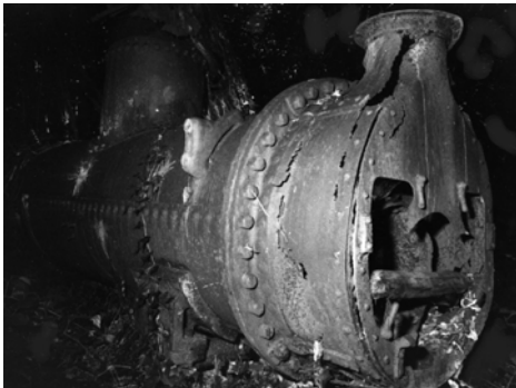
A gauche : les restes de la chaudière du captage du Marmot sont encore bien visibles près des ruines du poste d'entretien.
